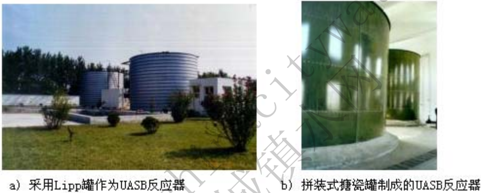
图8 Lipp罐(a)和拼装式搪瓷罐(b)制成的UASB反应器
