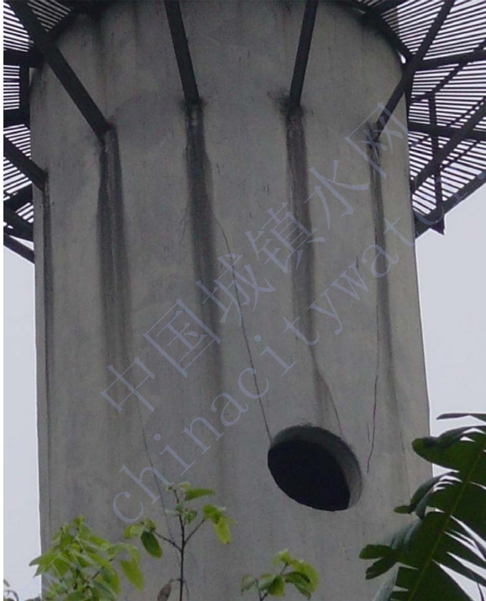
图3-5 水塔钢筋混凝土筒壁产生裂缝
