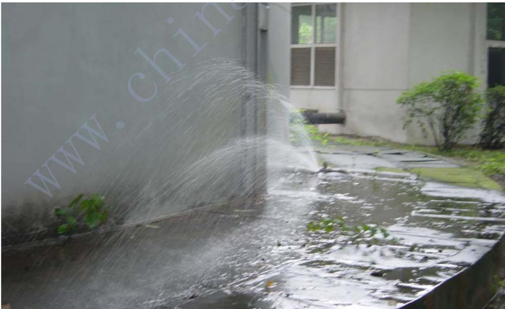
图3-4 一根入构筑物管破坏情况。
