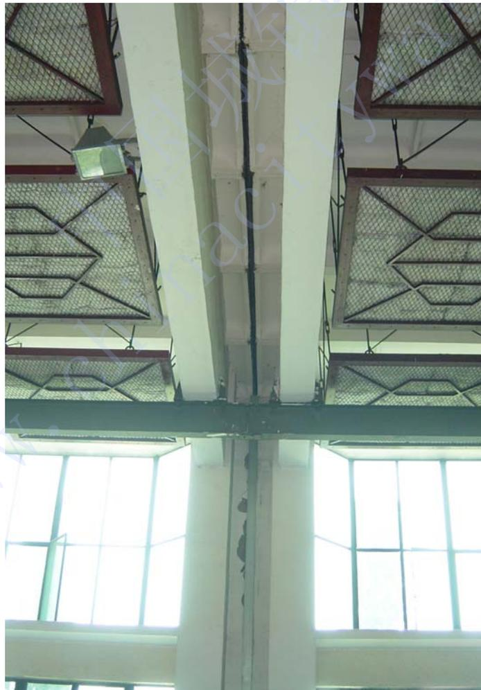
图3-3 某送水泵房变形缝变化情况
