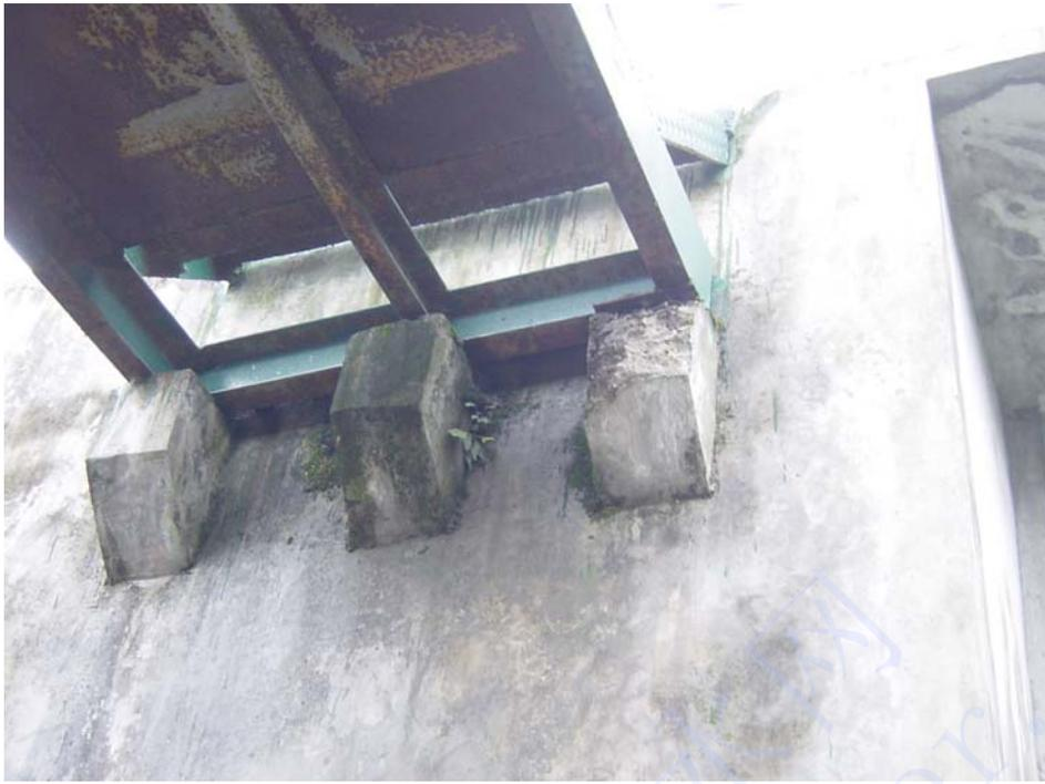
图3-2 某连接走道支座破坏
