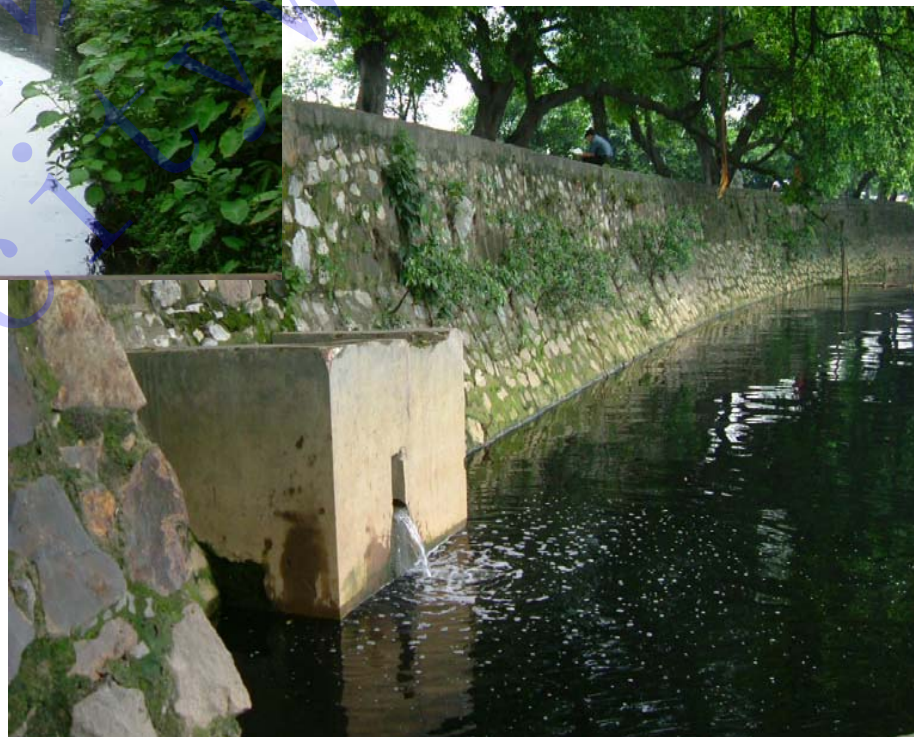
某市河涌现状
